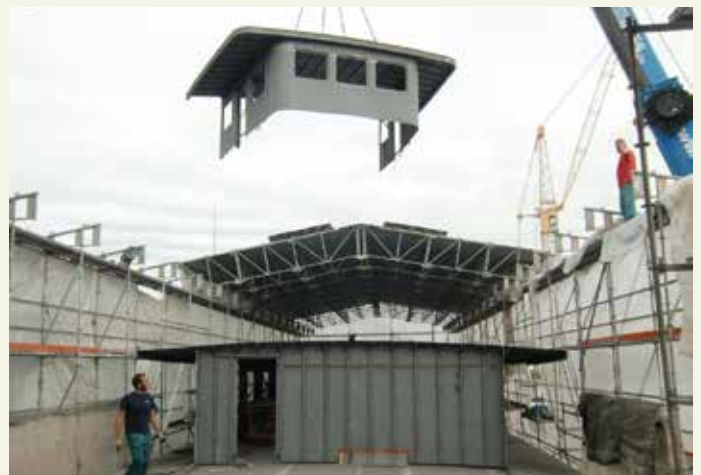
Am 24.08.2017 konnte das Deck dann in 6 Teilen aufgesetzt werden. Ein Gewaltakt, der zudem auch ein Höchstmaß an Präzision erforderte.
