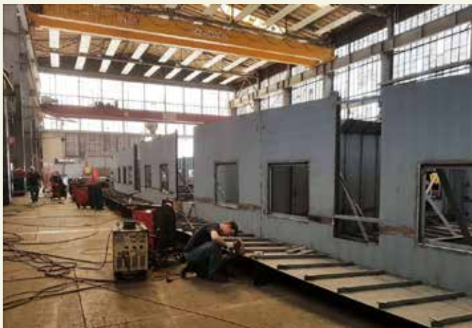
In der ÖSWAG Werft in Linz wurde der gesamte gigantische Deck-Aufbau in der Halle auf dem Kopf liegend vorgebaut ...
